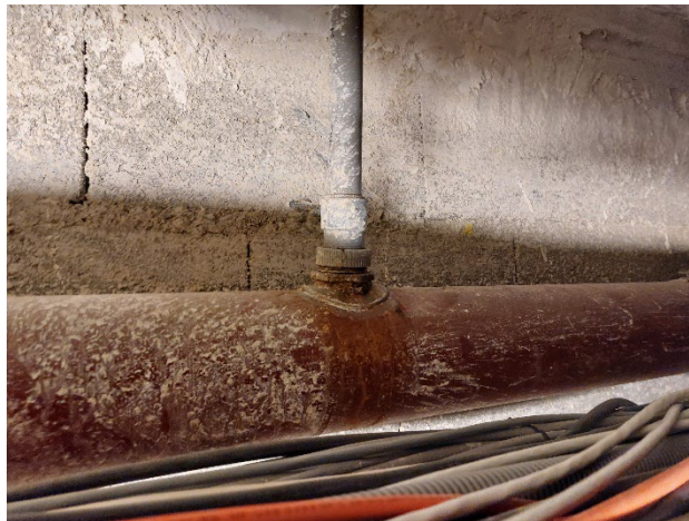
Raccordement des condensats CTA « Lille »
